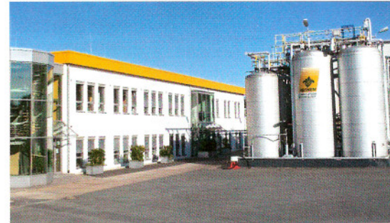
Energieeffizient: Das neue Sozialgebäude wird mit Geothermie beheizt und gekühlt.
